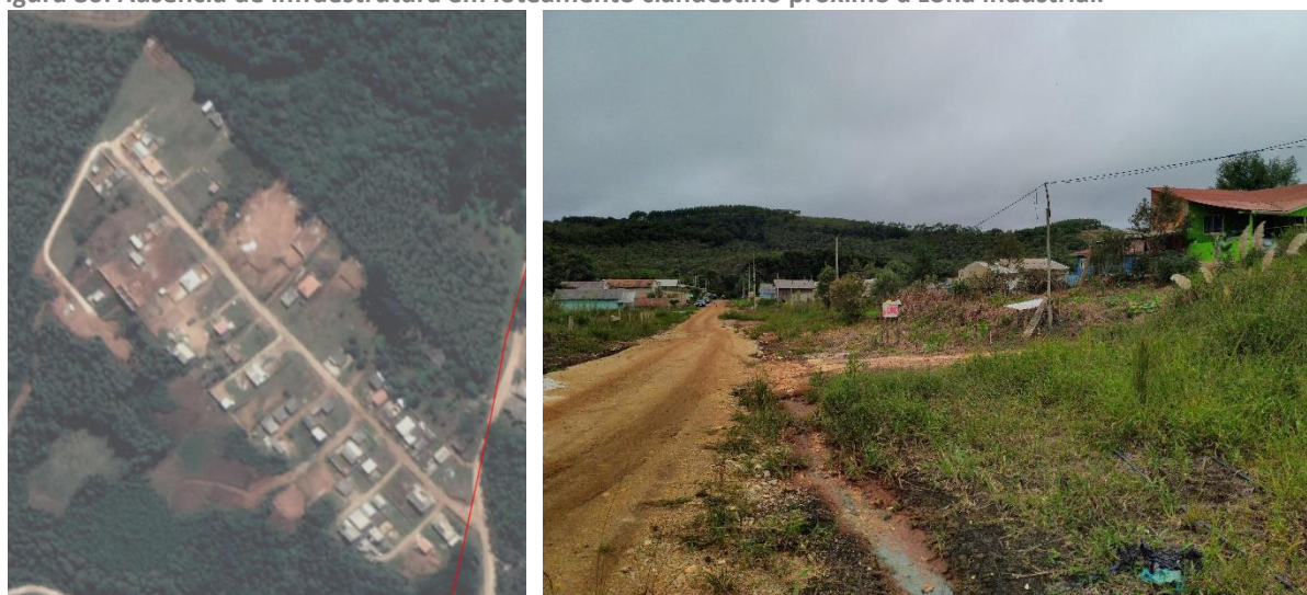
Figura 80: Ausência de infraestrutura em loteamento clandestino próximo à zona industrial.
