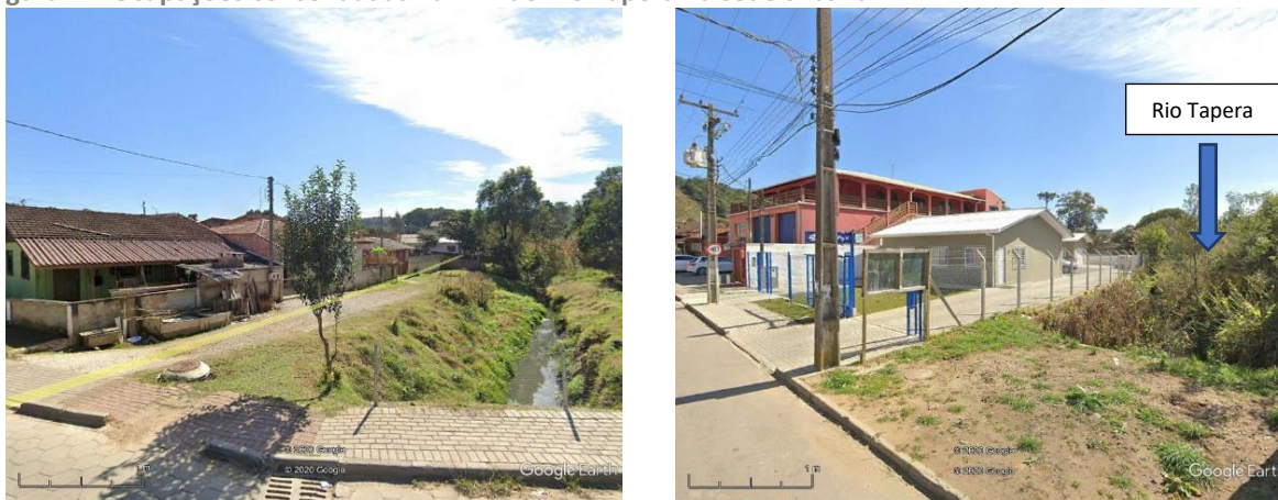
Figura 27: Ocupações consolidadas na APP do Rio Tapera na sede urbana.
