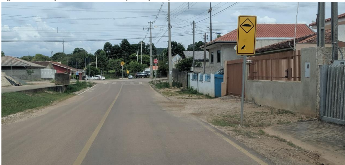
Figura 94: Indicação de lombada sem a presença de quebra-molas
