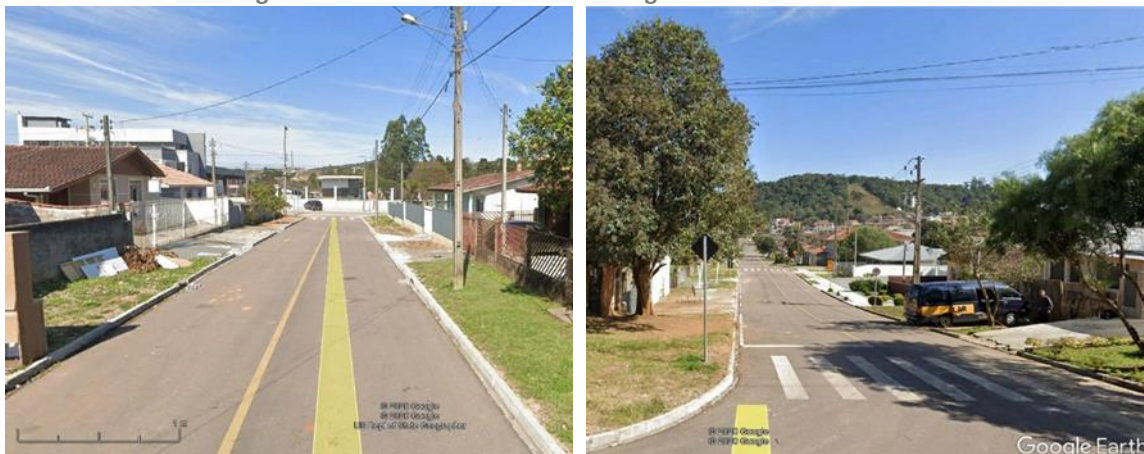
Figura 119: Rede de drenagem existente no Bairro Jardim Progresso.
