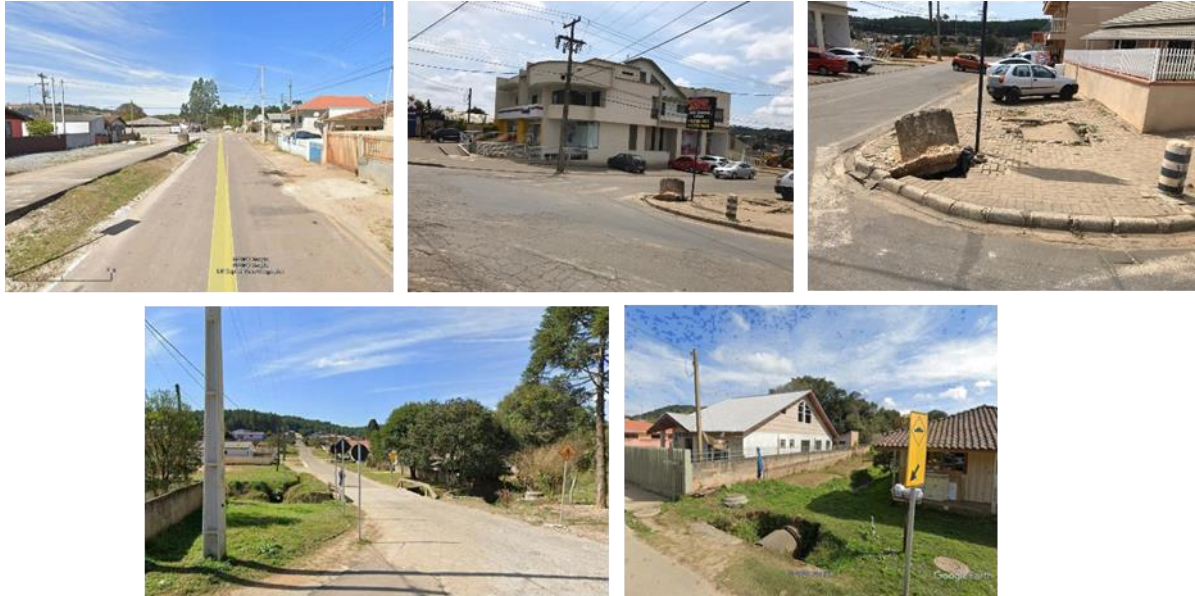
Figura 121: Pontos críticos de alagamento na sede urbana.
