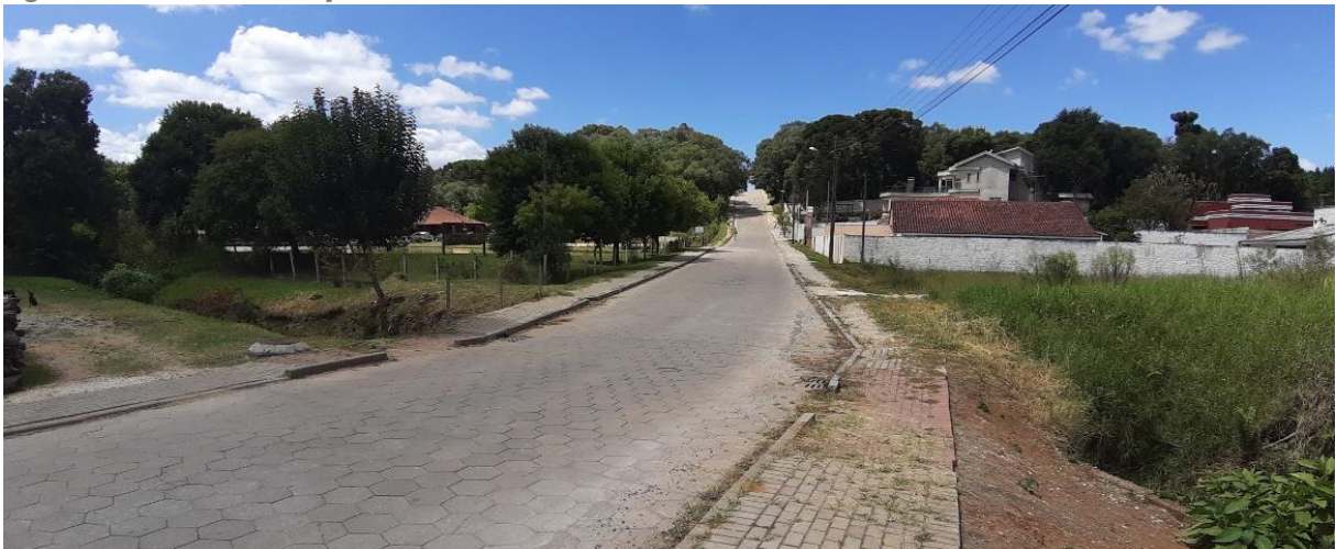
Figura 91: Falta de sinalização horizontal na Rua Francisco Rocha
