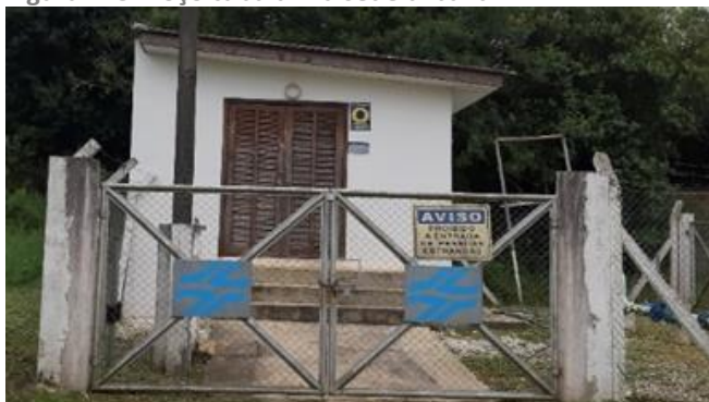
Figura 115: Poço tubular na sede urbana
