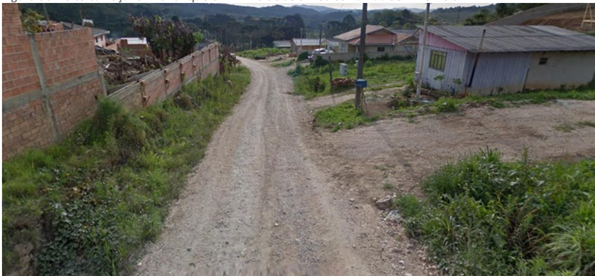
Figura 96: Leito carroçável menor que o mínimo de seis metros na Rua Sem Nome 027
