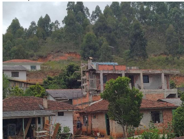
Novas construções em encosta, no bairro Boqueirão.
