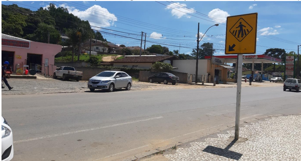
Figura 92: Pintura da travessia de pedestre desgastada na Rua Benjamim Constant Teixeira (rodovia urbana)
