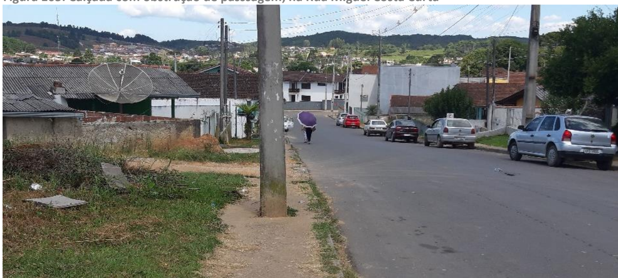
Figura 105: Calçada com obstrução de passagem, na Rua Miguel Costa Curta
