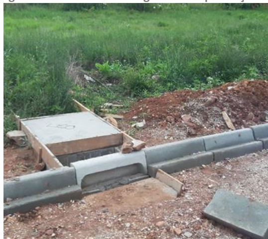
Figura 118: Rede de drenagem em implantação na Rua Bento Taborda dos Santos, via sem pavimentação
